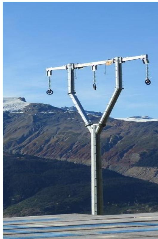
3、变电站构架：变电站是电力系统中变换电压、接受和分配电能、控制电力的流向和调整电压的电力设施，它通过其变压器将各级电压的电网联系起来。在电力系统中，变电站是输电和配电的集结点。因此，变电站整体构架的性能直接影响到变电站工作效率。变电站构架主要有角钢、钢管、钢板等钢材组成，构件之间通过焊接或者螺栓连接，构架连接节点比较复杂，一般采用柱头形式或者法兰形式，要求外观美观，广泛应用于变电站内各种设备和导线之间的支撑功能。
